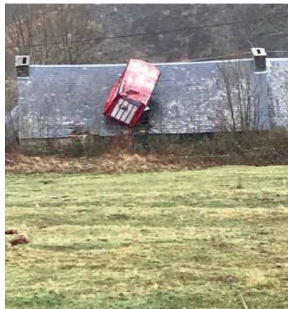
Une bétailère rouge sur le toit d'une grange à Aspin-Aure après les intempéries de décembre 2019 (photo : mairie Aspin-Aure)
