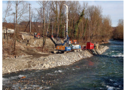
Travaux pour la reconstruction du pont de Saint-Laurent-de-N. (photo : R. Spinginsfeld)
